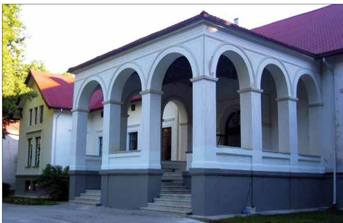
Pruuna mõisas asuva Lehtse põhikooli hiljuti remonditud fassaad.
