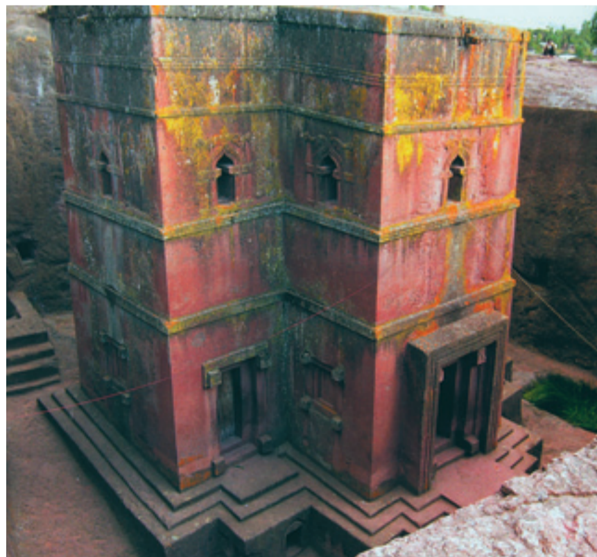
Etiopia Lalibela kaljukirikuid, mis on raiatud otse vulkaanilisse tuffi maapinnast allpool, kahjustab nii seest kui ka väljast vesi. Foto raamatust
