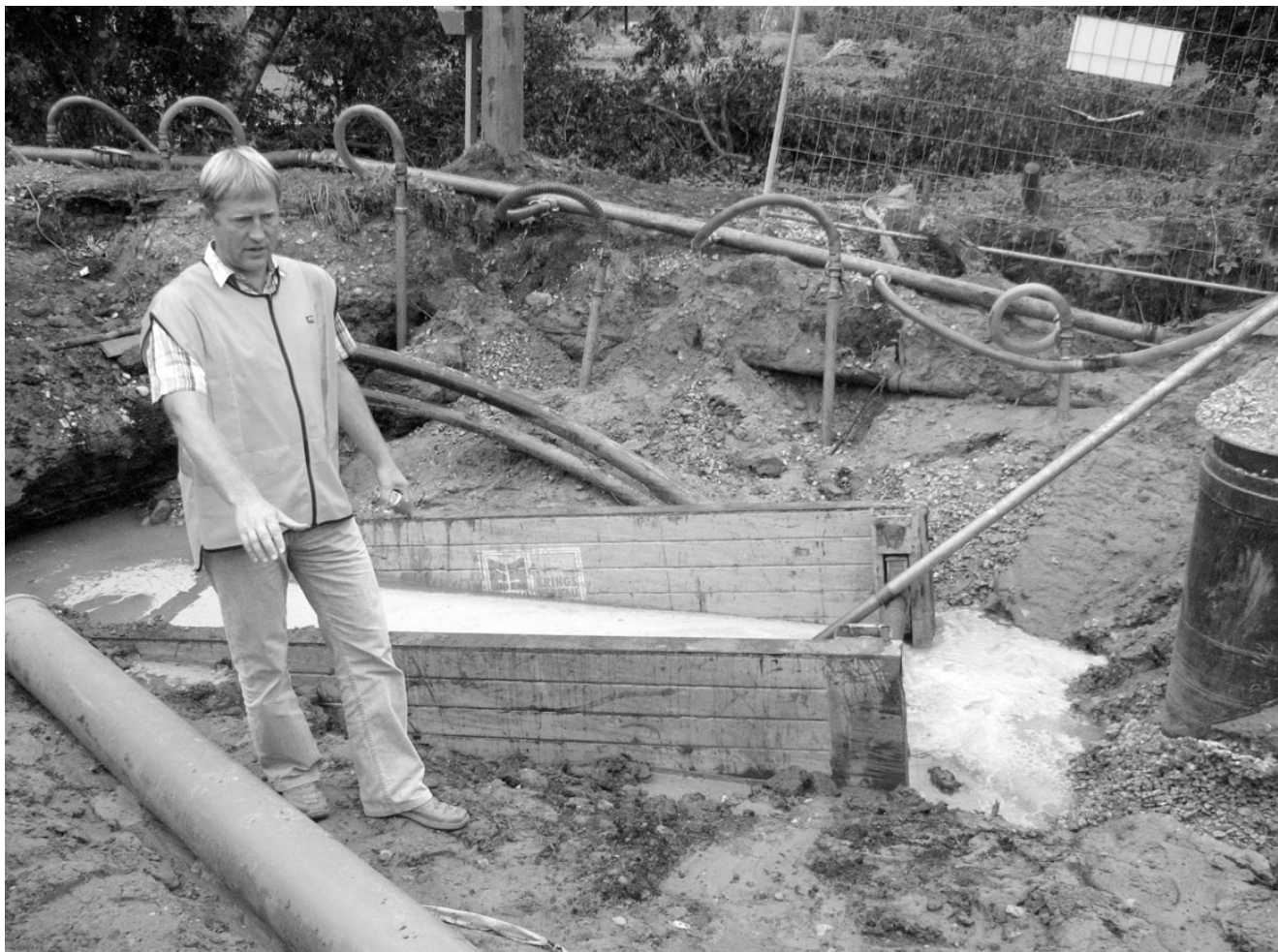
Harri Vihalemm näitab, kuidas Kase tänavas pumbati teisipäeva hommikul vett välja Lätist toodud nõelpumpadega, et ehitajad saaksid tööd edasi teha. Foto: Sirje Veldi
