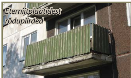
Poollainelistest asbesttsementplaatidest ripplagi
