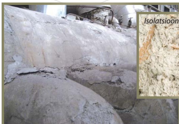
Asbestiga isoleeritud kütetorud
